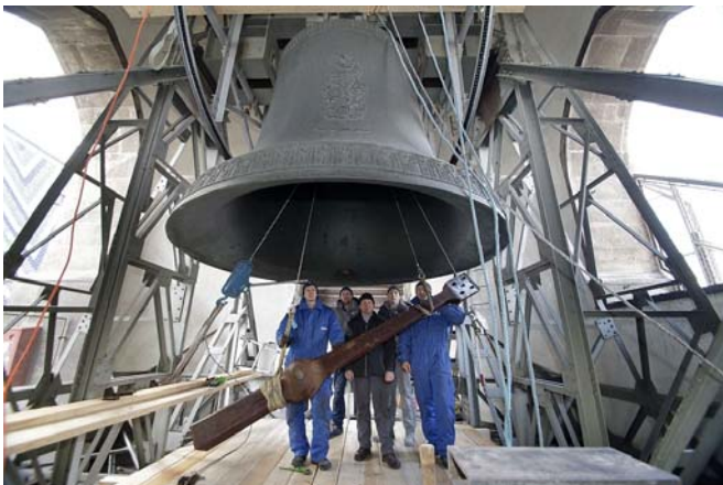
Abb. 9: Wien, Stephansdom: Demontage des alten Klöppels der Pummerin (Photo: Grassmayr).
